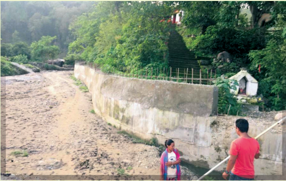
कोटिला वाल निर्माण
